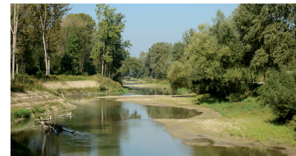
Beispiel für einen naturnahen Umgehungsbach beim Donaukraftwerk Ottensheim-Wilhering
