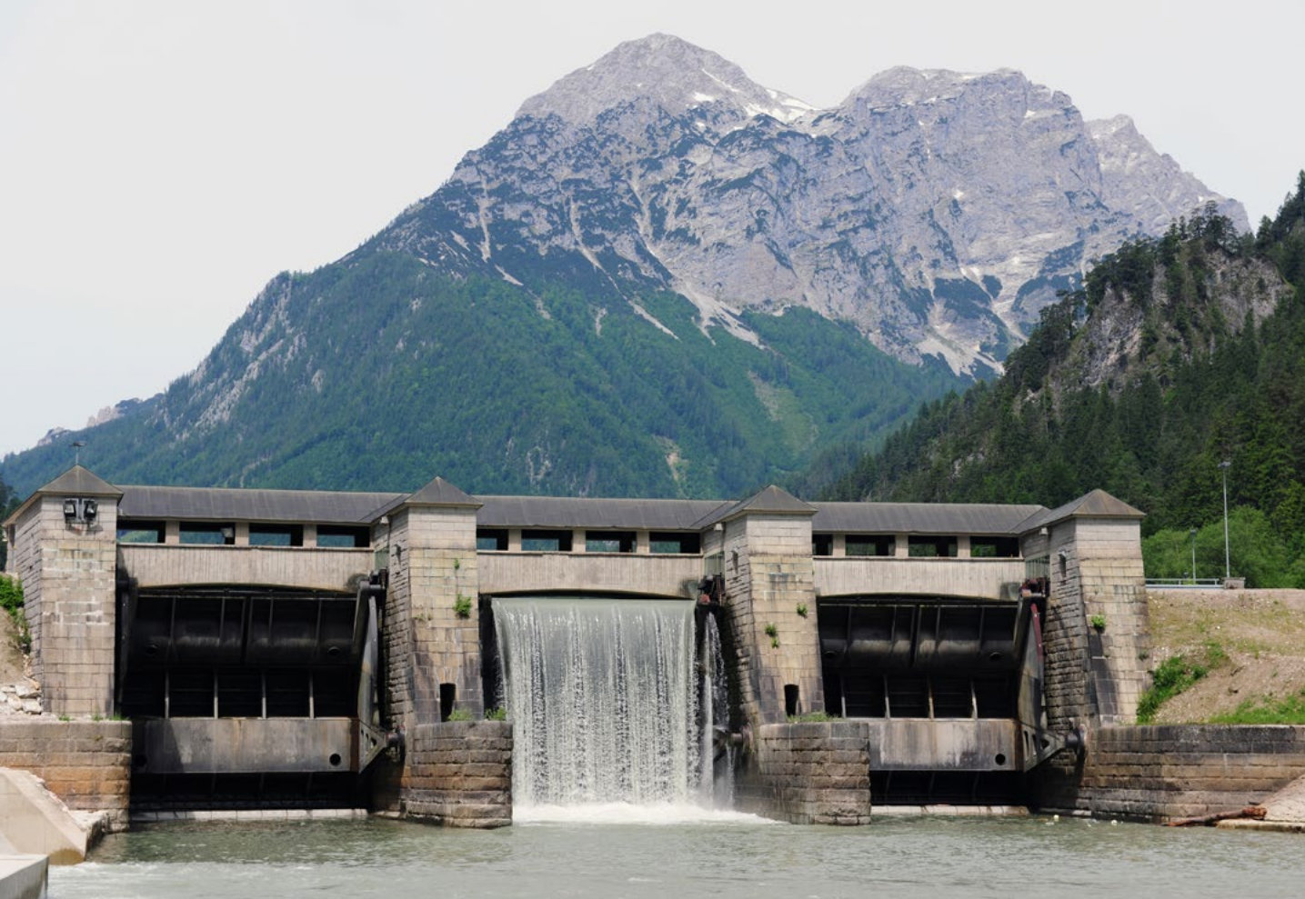
Kraftwerk Hieflau, Wehr Gstatterboden
