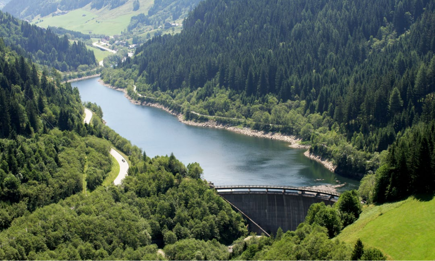
Stausee und Sperre Großsölk
