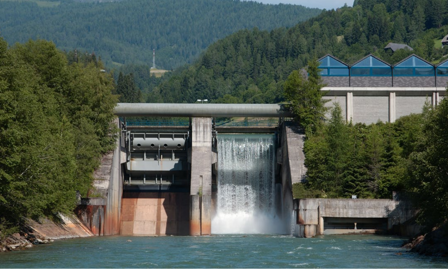
Kraftwerk Bodendorf, Wehranlage und Krafthaus
