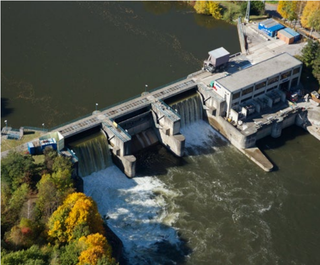
Kraftwerk Friesach, Kraftwerk Weinzödl
