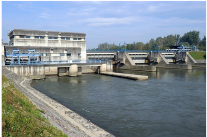
Kraftwerk Gralla, Kraftwerke Retznei (links), Obervogau, Kraftwerk Spielfeld
