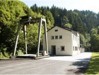
Kraftwerk St. Martin
