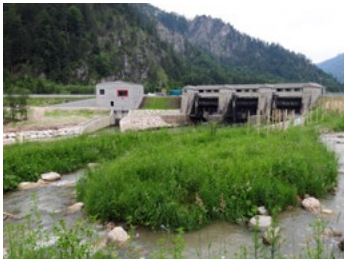
Wehr Gstatteboden mit Fisch- und Organismenwanderhilfe
