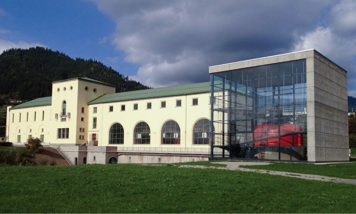
Krafthaus Pernegg mit Schauturbine
