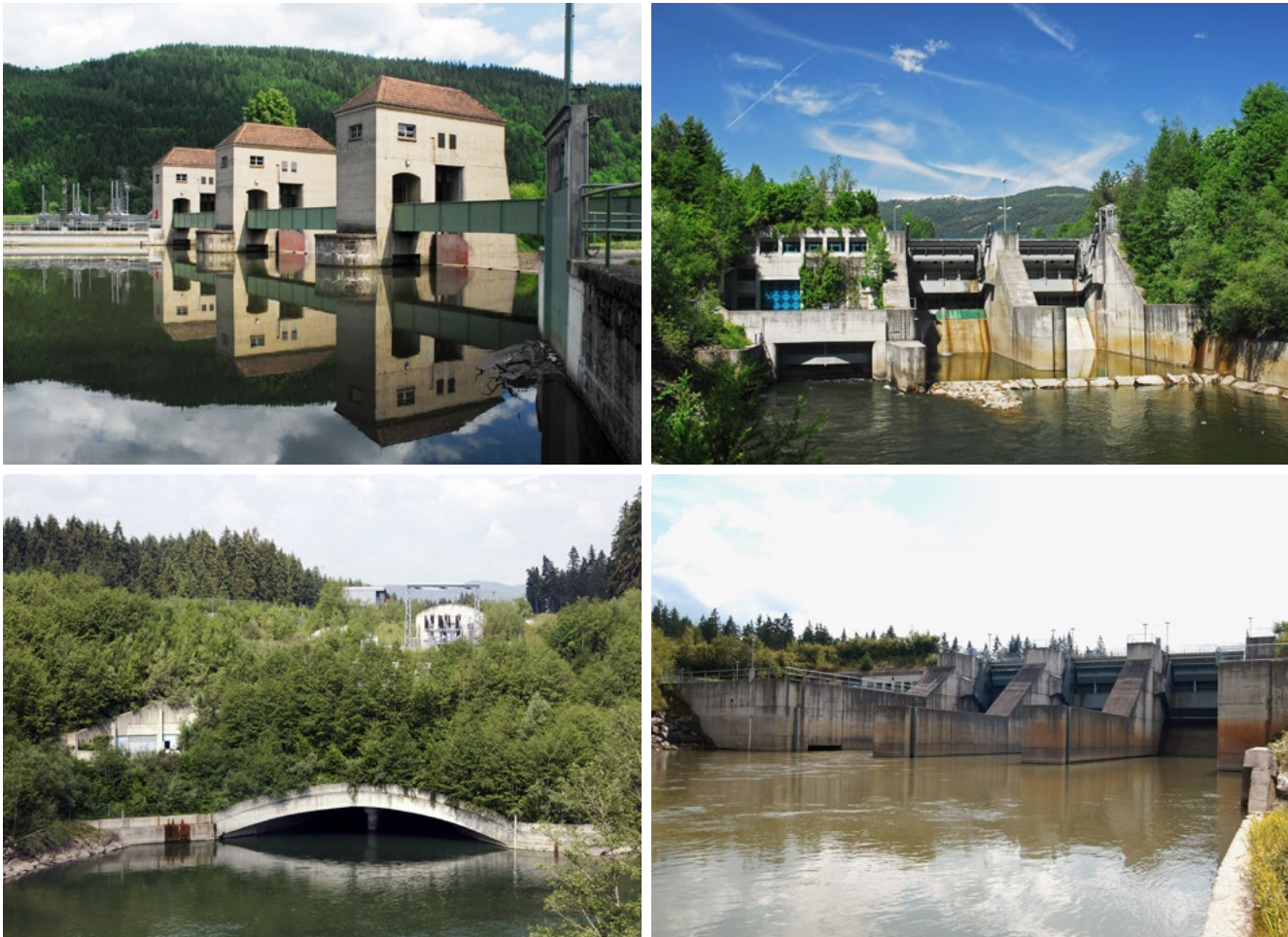
Kraftwerk Dionysen, verwachsenes Krafthaus Fischeing
