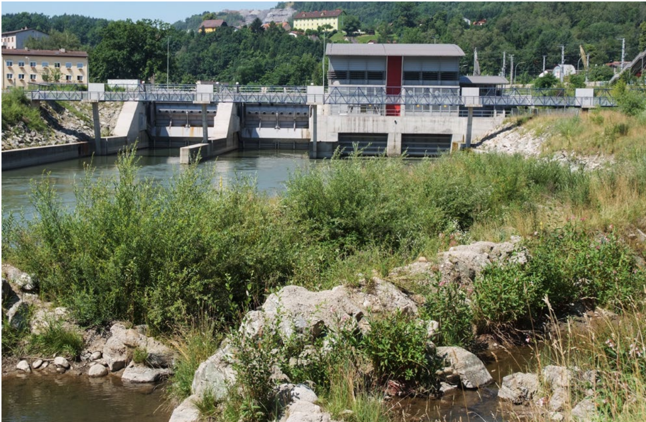
StadtKraftWerk Leoben mit Fischwanderhilfe
