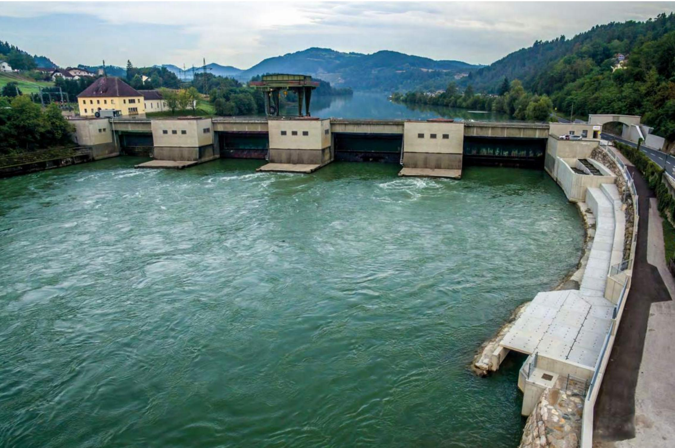
Abb. 12: Fischwanderhilfe beim Kraftwerk Lavamünd, unterwasserseitige Ansicht: Einstiegsbereich als Tunnelvariante mit Belichtungselementen und anschließenden Becken, eingefasst von einer Hochwasserschutzmauer.
