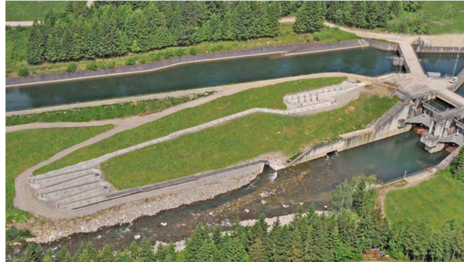
Abb. 3: Die erste echte Bewährungsprobe des *enature*® Fischpass-Systems in der Natur fand an der Fischaufstiegshilfe am Wehr Rottau an der Möll statt. Danach waren auch die Entwickler selbst überzeugt, dass der neue Fischpasstyp funktioniert.
