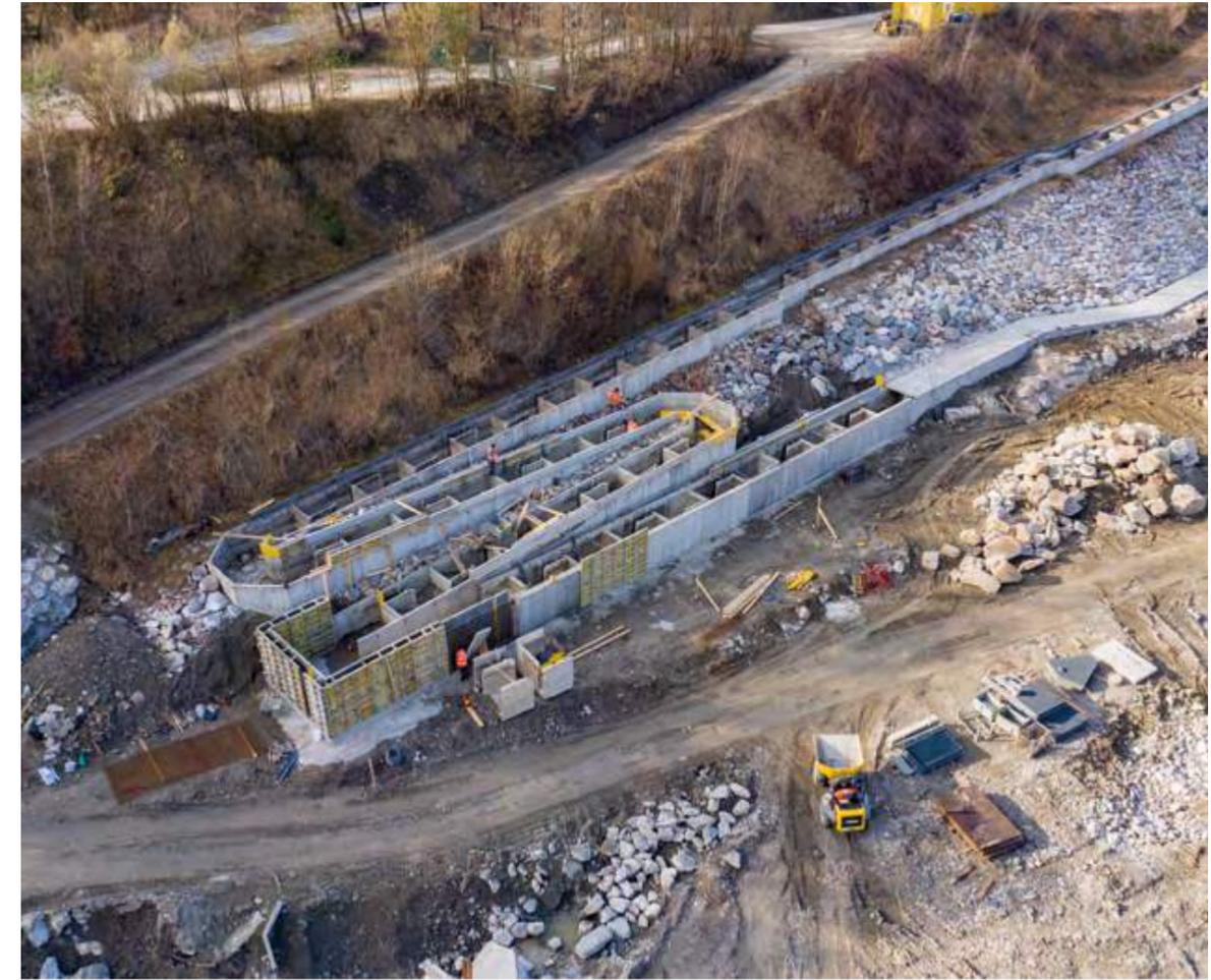
Abb. 17: Fischwanderhilfe beim Kraftwerk Rosegg-St. Jakob/Wehr St. Martin: Sanierungsarbeiten nach dem Hochwasserereignis im Oktober 2018.
