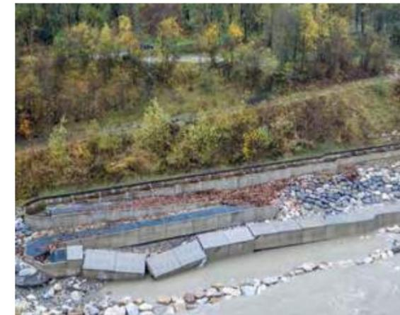
Abb. 16: Fischwanderhilfe beim Kraftwerk Rosegg-St. Jakob/Wehr St. Martin während bzw. unmittelbar nach dem Hochwasser im Oktober 2018.
