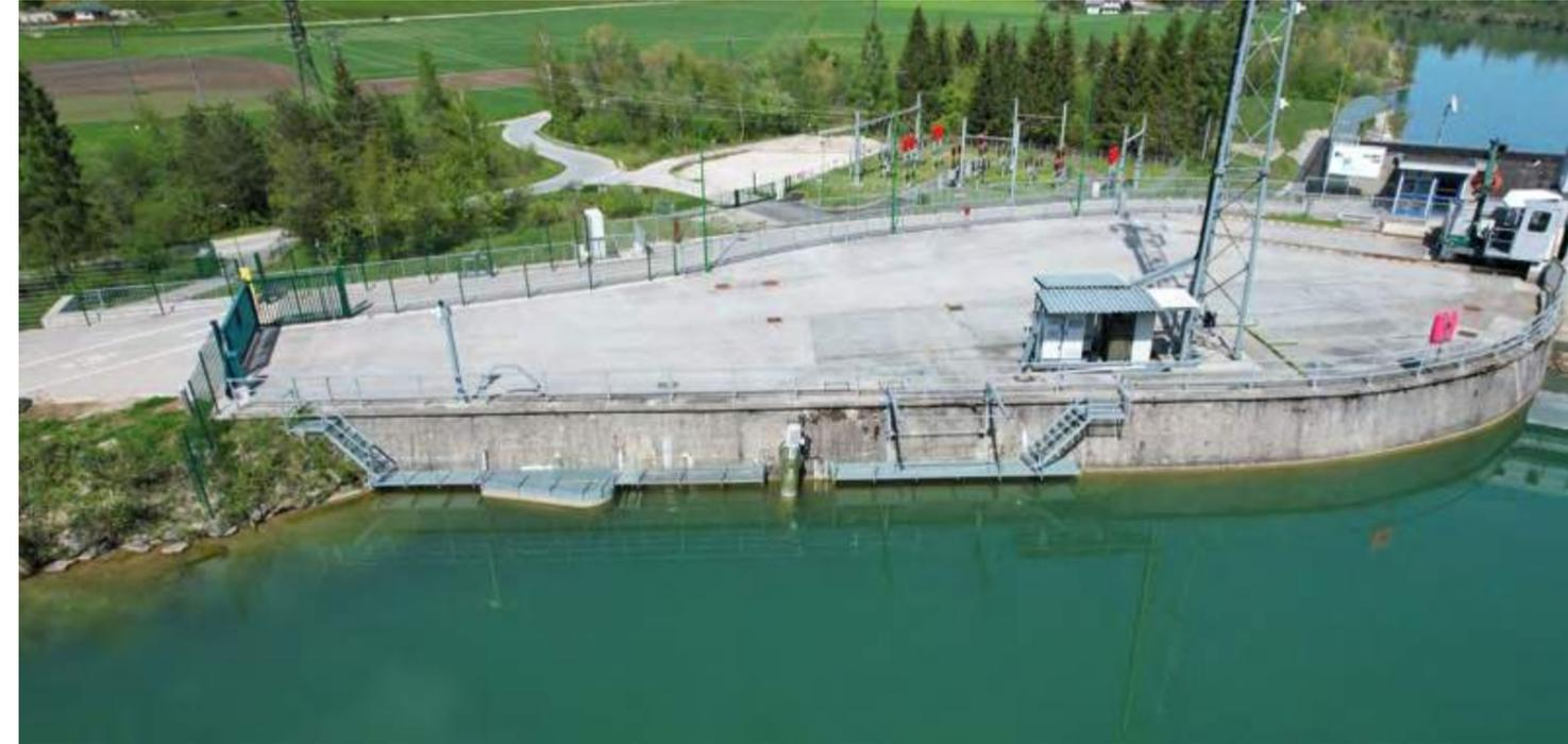
Abb. 22: Fischwanderhilfe beim Kraftwerk Annabrücke: Betreuungssteg mit Tauchwand, Totholz- und Geschwemmsel-Abweiser im oberwasserseitigen Ausstiegsbereich.
