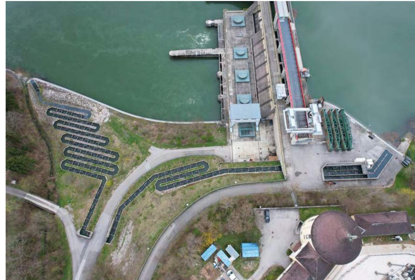
Abb. 5a, b: Die „Grossglockner Hochalpenstraße“ der Fischaufstiege. Kehren 1 bis 10 am *enature*® Fishpass beim Draukraftwerk Schwabeck.
