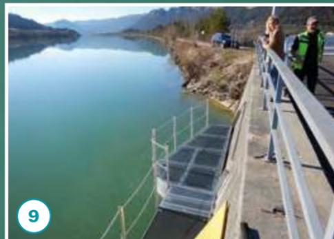
Oberwasserseitiger Ausstieg mit Wartungssteg und Tauchwand zur Verhinderung von Totholz- und Geschwemmeleintrag, rechts die Notdotationspumpe.
