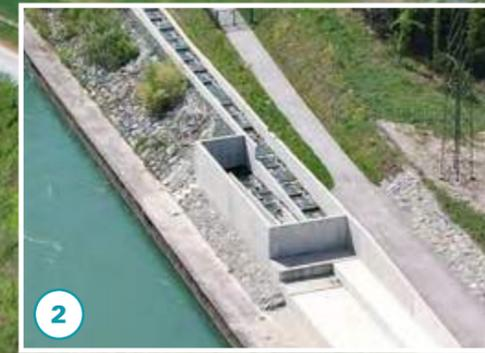
Unterwasserseitiger Trassenverlauf parallel zur Ufermauer im vom Hochwasser beeinflussten Bereich, mit hochgezogener Mauer bzw. Betonplatten geschützt.
