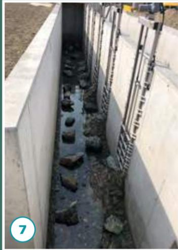
Dotations- und Verteilbauwerk mit automatisierten stauspiegelabhängig gesteuerten Schiebern.
