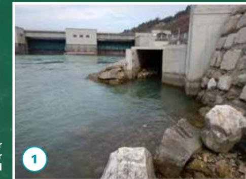
Unterwasserseitiger Einstieg, hochwassersicher mit Betonplatten und Steinschichtung gesichert.
