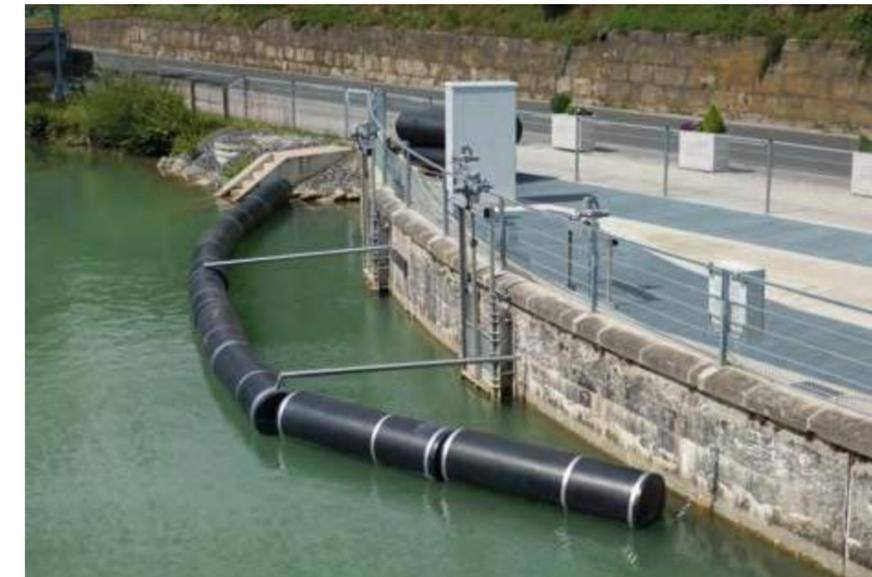
Abb. 13: Fischwanderhilfe beim Kraftwerk Lavamünd, oberwasserseitig: Verlauf mit Gitterrosten abgedeckt, im Ausstiegsbereich gegliederte Schwimmstoffabweiser zur Verhinderung von Verklausungen durch Geschiebe- und Schwebstoffeintrag.
