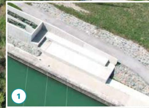
Unterwasserseitiger Fischeinstieg, hochwassersicher mit Betonplatten mit Belichtungselementen abgedeckt.
