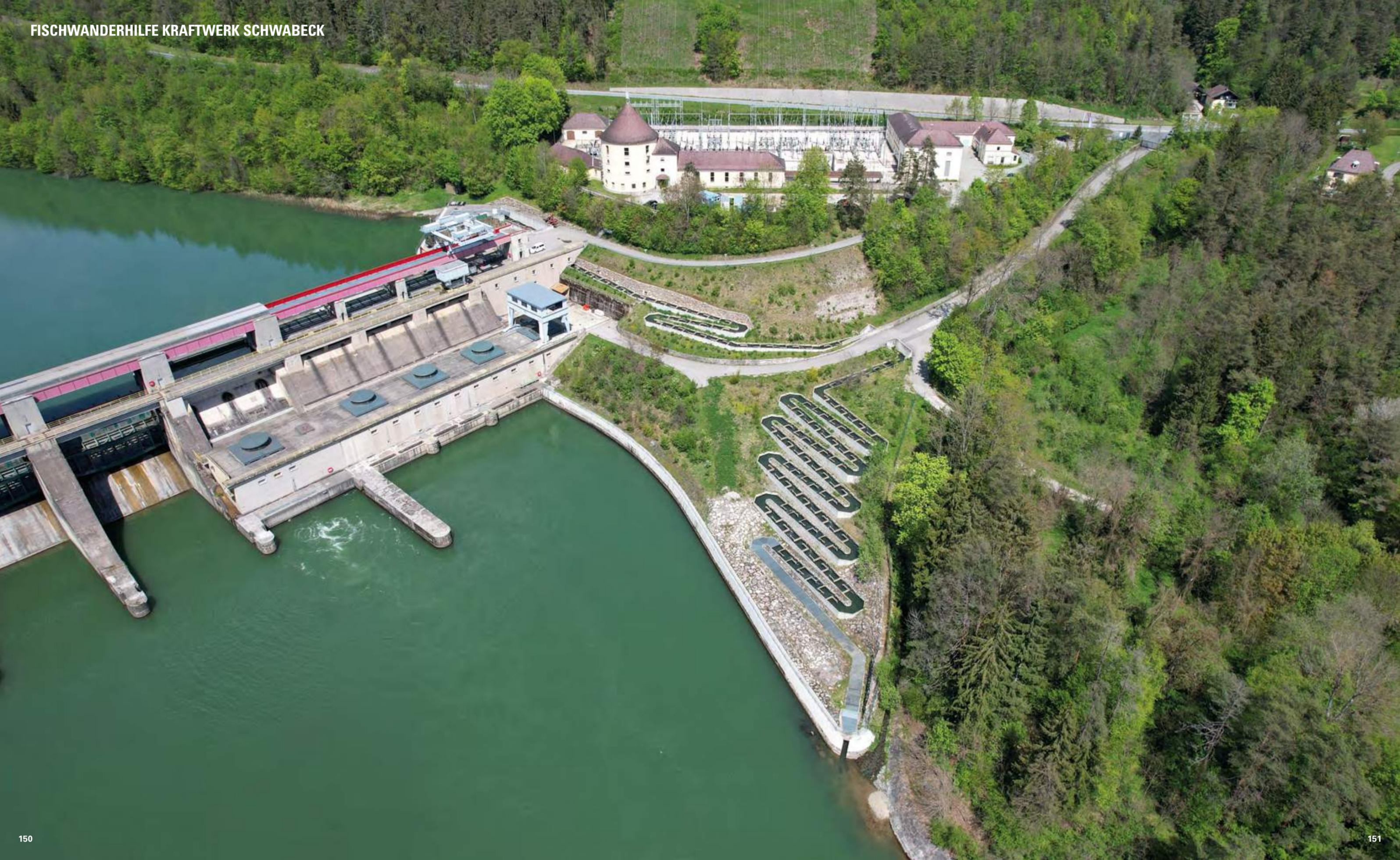
Die unterwasserseitige Einbindung wurde durch einen Einschnitt in die Ufermauer erreicht.
