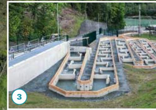
3 Der oberwasserseitige Trassenverlauf wurde an das Gelände angepasst und verläuft serpentinartig.
