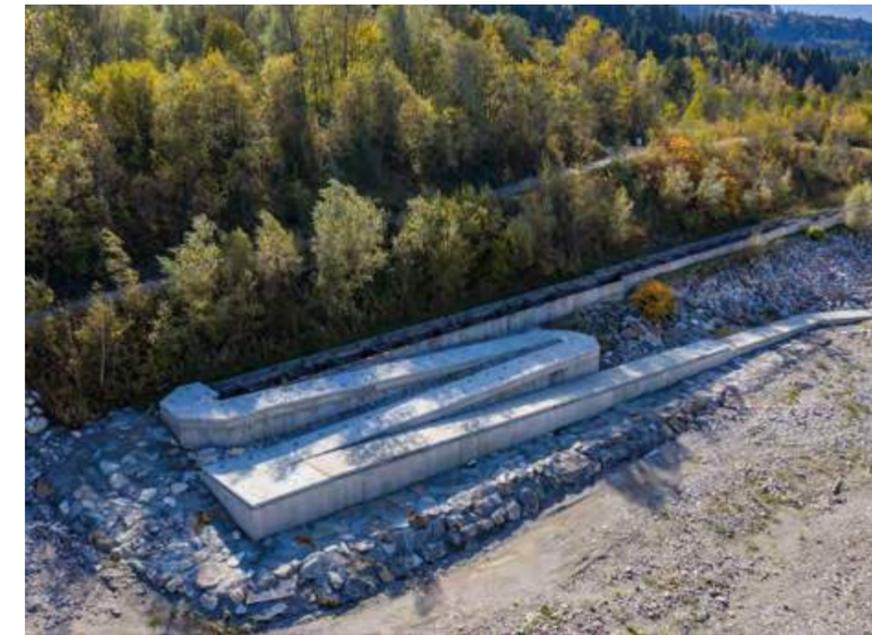
Abb. 18: Fischwanderhilfe beim Kraftwerk Rosegg-St. Jakob/Wehr St. Martin nach den Sanierungsarbeiten nach dem Hochwasserereignis Oktober 2018.
