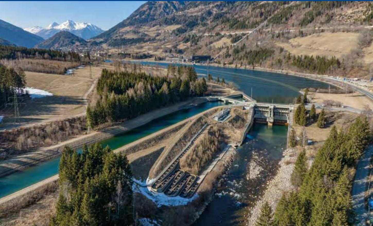
Abb. 9: Die Fischwanderhilfe beim Wehr Rottau überwindet 15,5 m Höhenunterschied und bindet die Möll-Restwasserstrecke über 101 Becken wieder an das Staubecken Rottau an. (Links im Bild: die Staubecken-Ausleitung „Sachsenwegkanal“ der Triebwasserlieferant für die Kraftstation Möllbrücke im tiefergelegenen Drautal).
