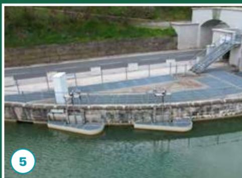
Wartungssteg am oberwasserseitigen Ausstieg mit Tauchwand zur Geschwemmsel- und Totholzabwehr. Oberwasserseitige Becken, mit Gitterrosten abgedeckt.
