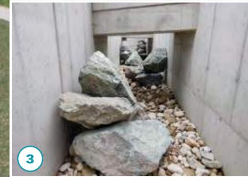
Steinstruktur zur Strömunglenkung im mit Gitterrosten und Betonplatte abgedeckten Bereich der Freiluftschaltanlage und der Kraftwerkszufahrt.
