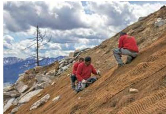
Abb. 6: Durch die eng dem Untergrund aufliegenden Kokosmatten werden der Oberboden, die eingebrachten Rasenziegel, aber auch Saatgut und Dünger gegen Erosion gesichert.
