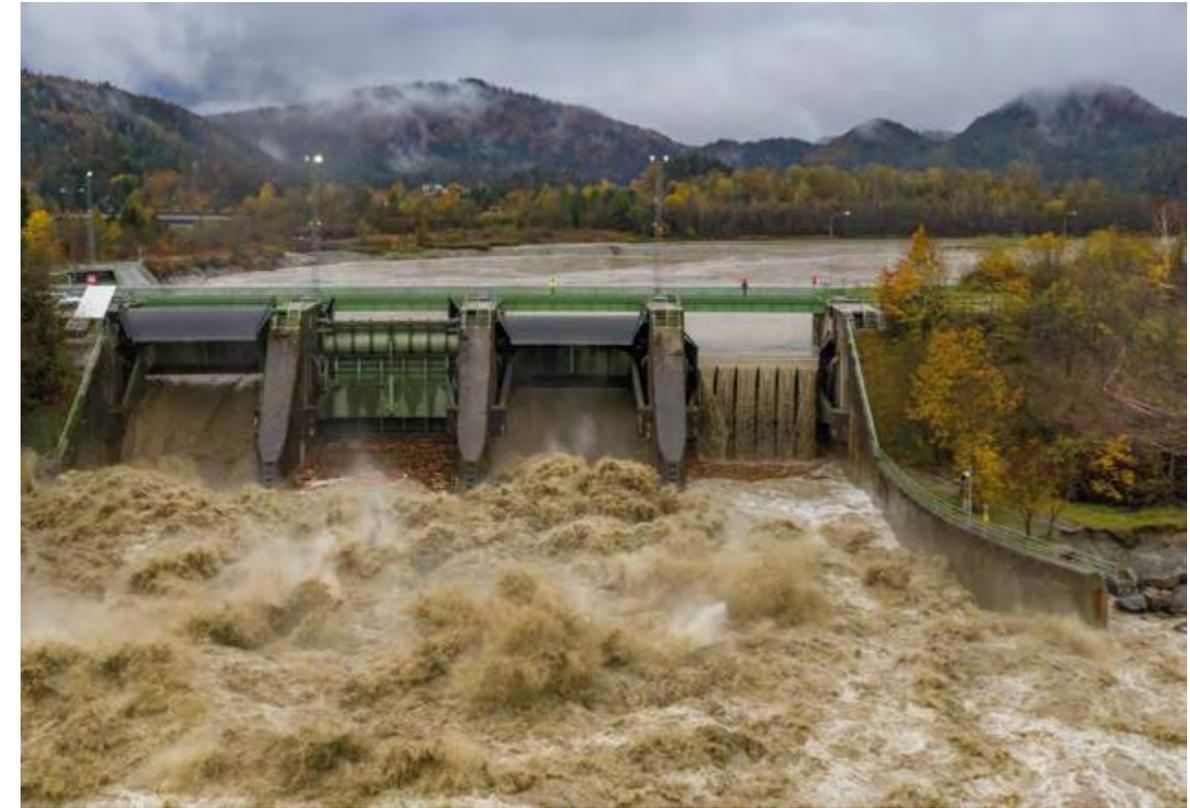
Abb. 10: Hochwasser im Oktober 2018 beim Kraftwerk Rosegg-St. Jakob/Wehr St. Martin. Am rechten Bildrand ist eine fortschreitende Zerstörung der Ufermauer durch die Wassermassen erkennbar.
