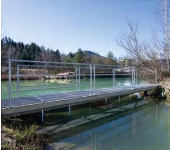
Abb. 19: Fischwanderhilfe beim Kraftwerk Rosegg-St. Jakob/Wehr St. Martin oberwasserseitiger Ausstieg, Betreuungssteg mit (unter Wasser liegender) Tauchwand bzw. Totholz- und Geschwemmsel-Abweiser.
