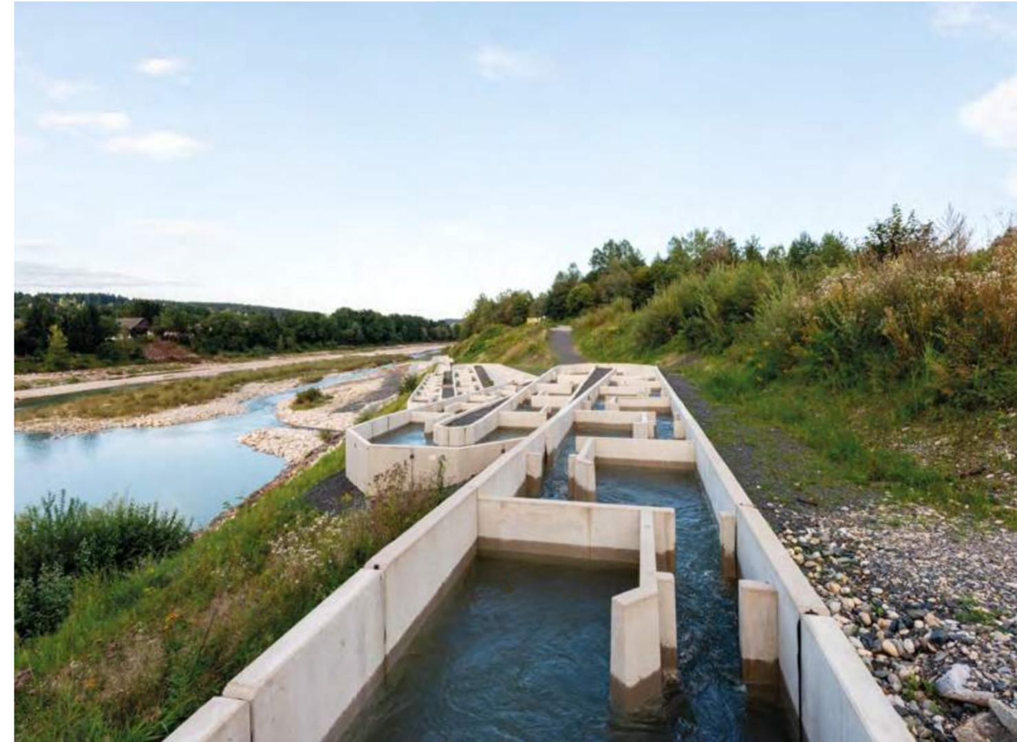
Abb. 1: Fischwanderhilfe beim Wehr St. Martin / Kraftwerk Rosegg-St. Jakob. Serpentinartiger Verlauf der Fischwanderhilfe im unterwasserseitigen Dammbereich.
