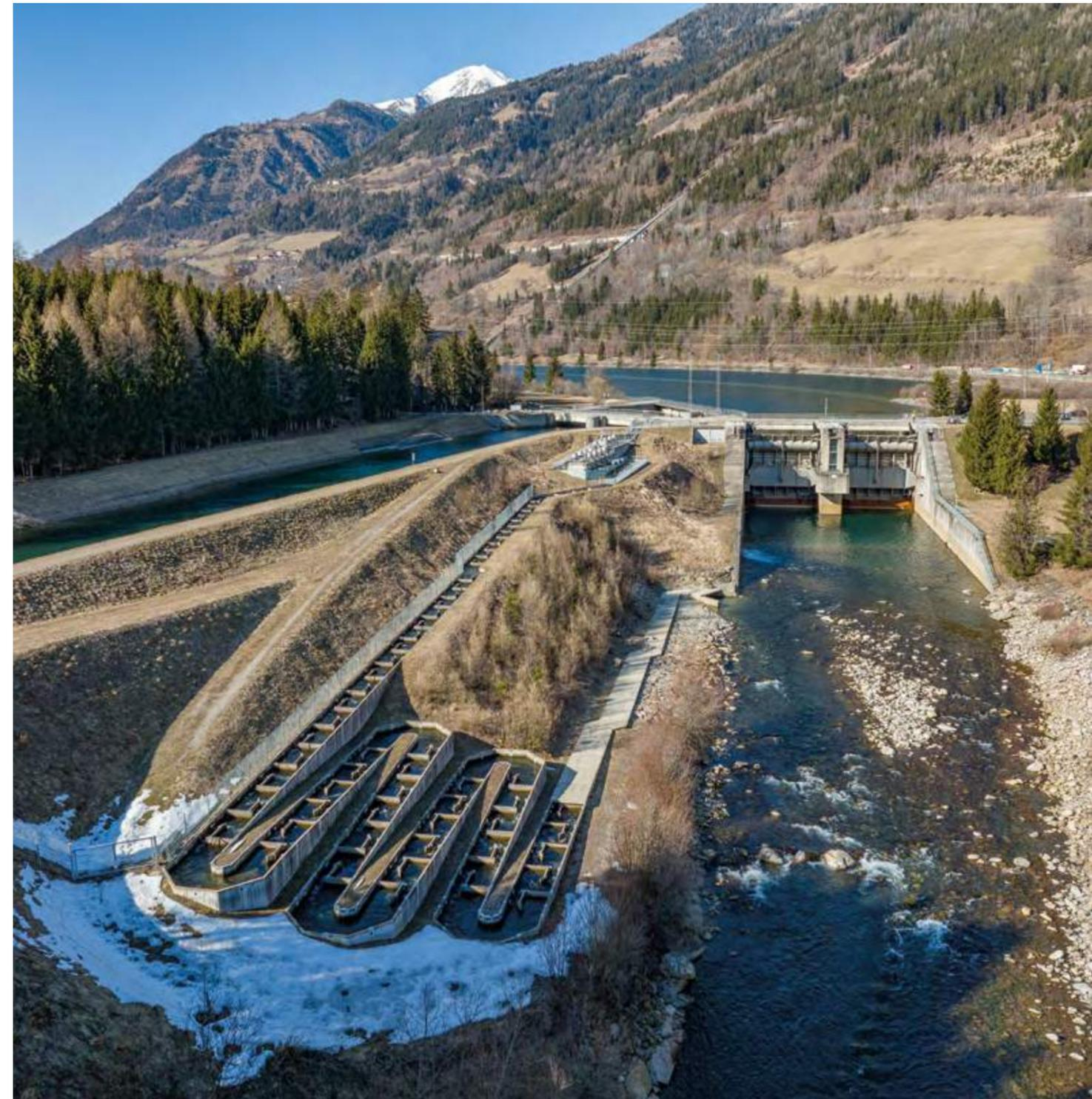
Abb. 3: Fischwanderhilfe am VERBUND-Kraftwerk Malta-Unterstufe/Wehr Rottau an der Möll. Die technische Fischwanderhilfe mit einer Länge von 435 m wurde 2012/13 in Form eines *enature*® Fishpass-Systems errichtet. Sie überwindet einen Höhenunterschied von 15,5 m.
