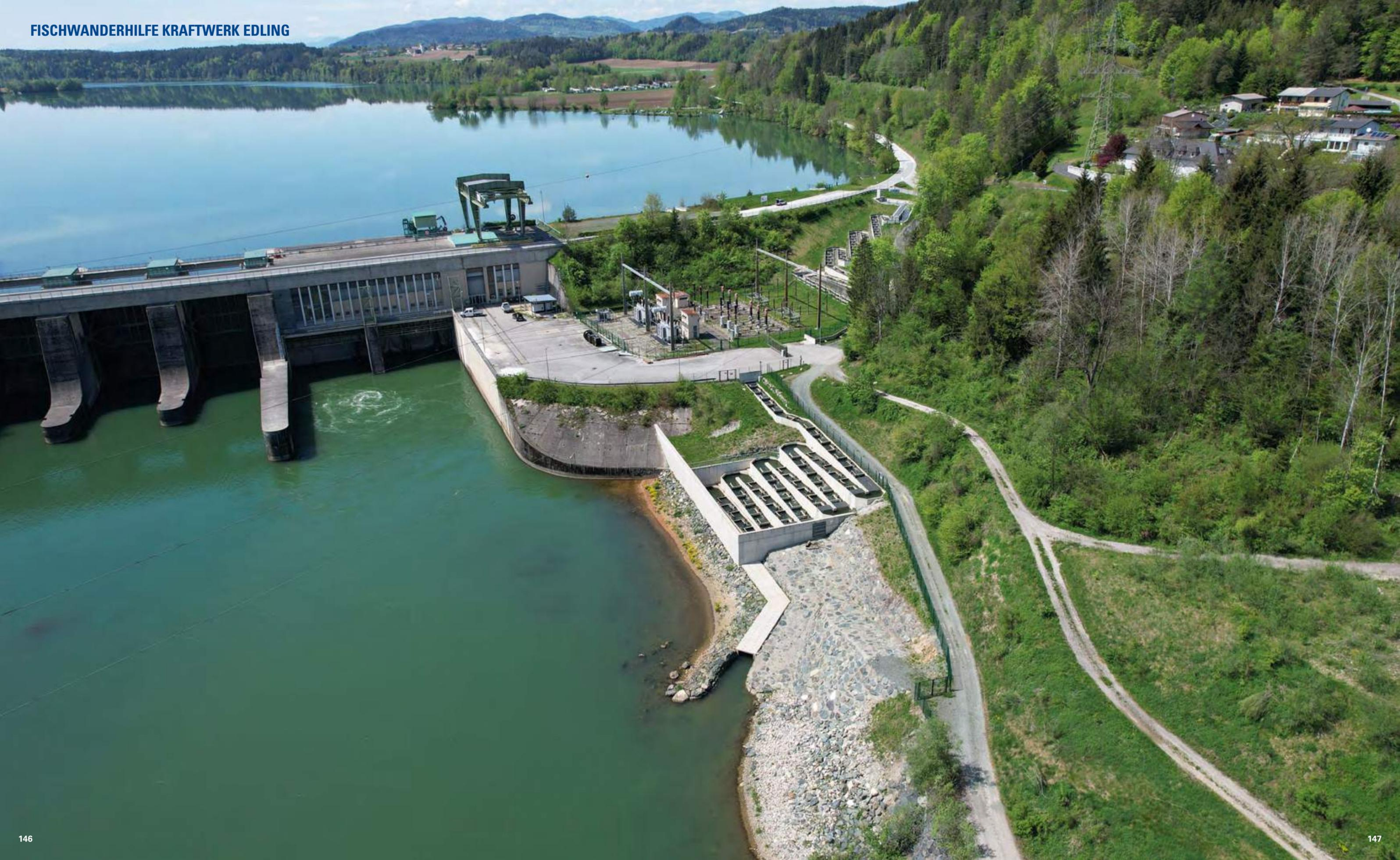
**Fischwanderhilfe Kraftwerk Edling**
