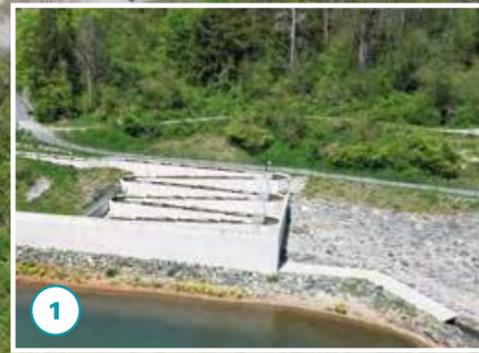
1 Unterwasserseitiger Fischeinstieg, zuerst hochwassersicher mit Betonplatten mit Belichtungselementen abgedeckt und in weiterer Folge hinter einer Hochwasserschutzmauer verlaufend.
