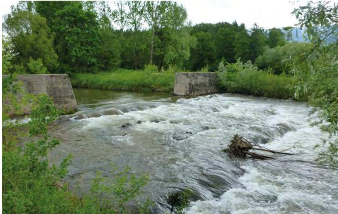
Abb. 2: Die Sohlstufe bei St. Andrä-Jakling (Absturzhöhe ca. 1,3 m) wurde zu einer aufgelösten Sohlrampe umgebaut, über mehrere Becken und Korridore können Fische nun diese Barriere überwinden.
