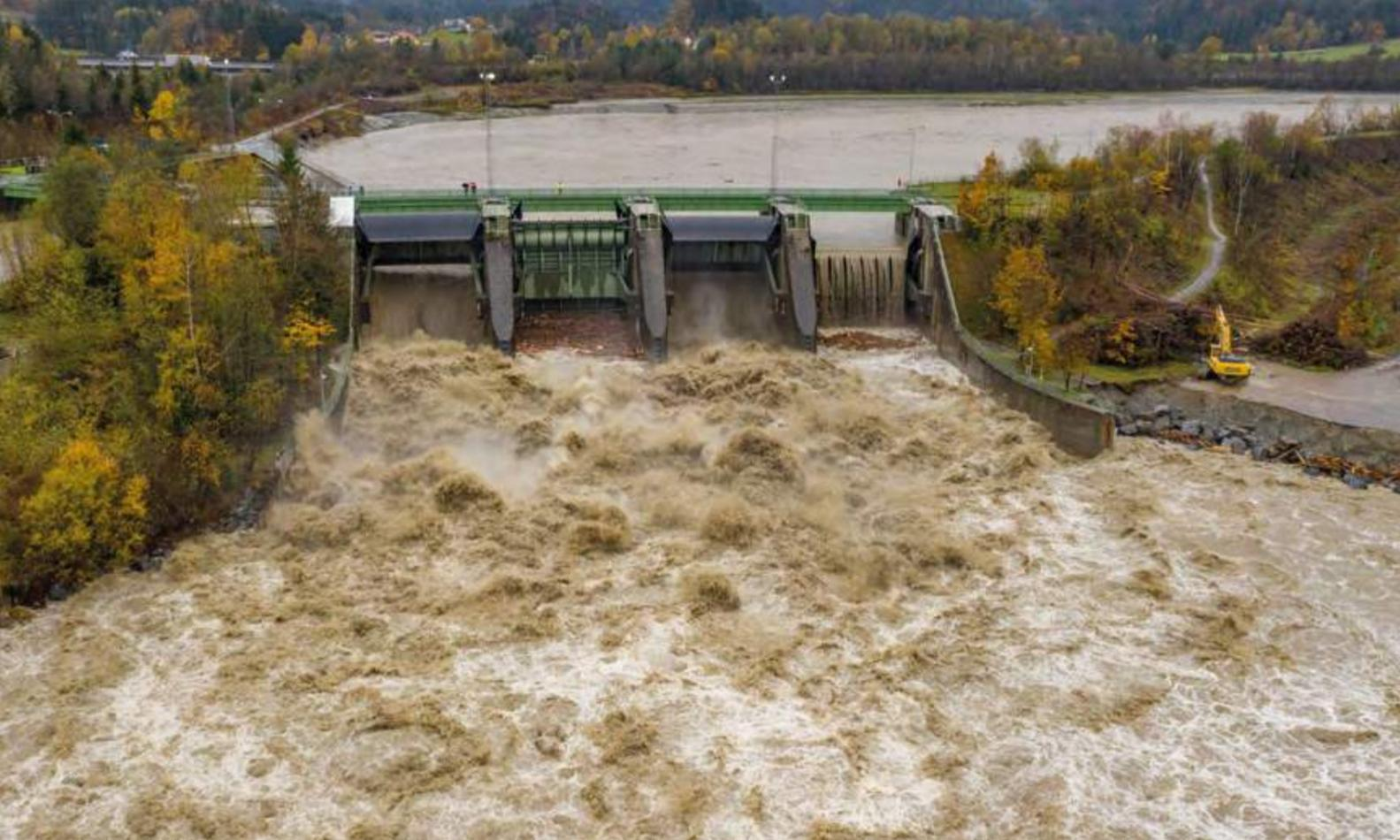
Abb. 14: Das Wehr St. Martin beim Kraftwerk Rosegg-St. Jakob, im Oktober 2018: Entfesselte Kräfte im Unterwasser überfluten und beschädigen Teile der Fischwanderhilfe und die gegenüberliegende Ufermauer.
