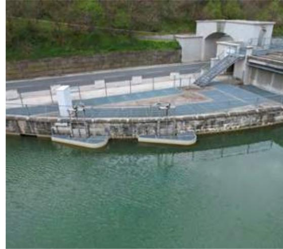
Abb. 20: Fischwanderhilfe beim Kraftwerk Lavamünd, oberwasserseitiger Ausstieg: Betreuungssteg mit Tauchwand, Totholz- und Geschwemmsel-Abweiser.
