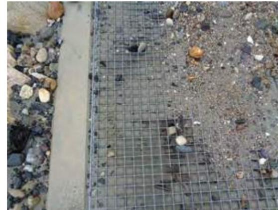
Abb. 10a, b, c, d: Fischwanderhilfe beim Kraftwerk Rosegg-St. Jakob/Wehr St Martin, nach dem Hochwasserereignis im Oktober 2014: Totholz- und Sedimentablagerung auf Gitterrosten im Einstiegsbereich bzw. mit Sediment verfüllte Becken.
