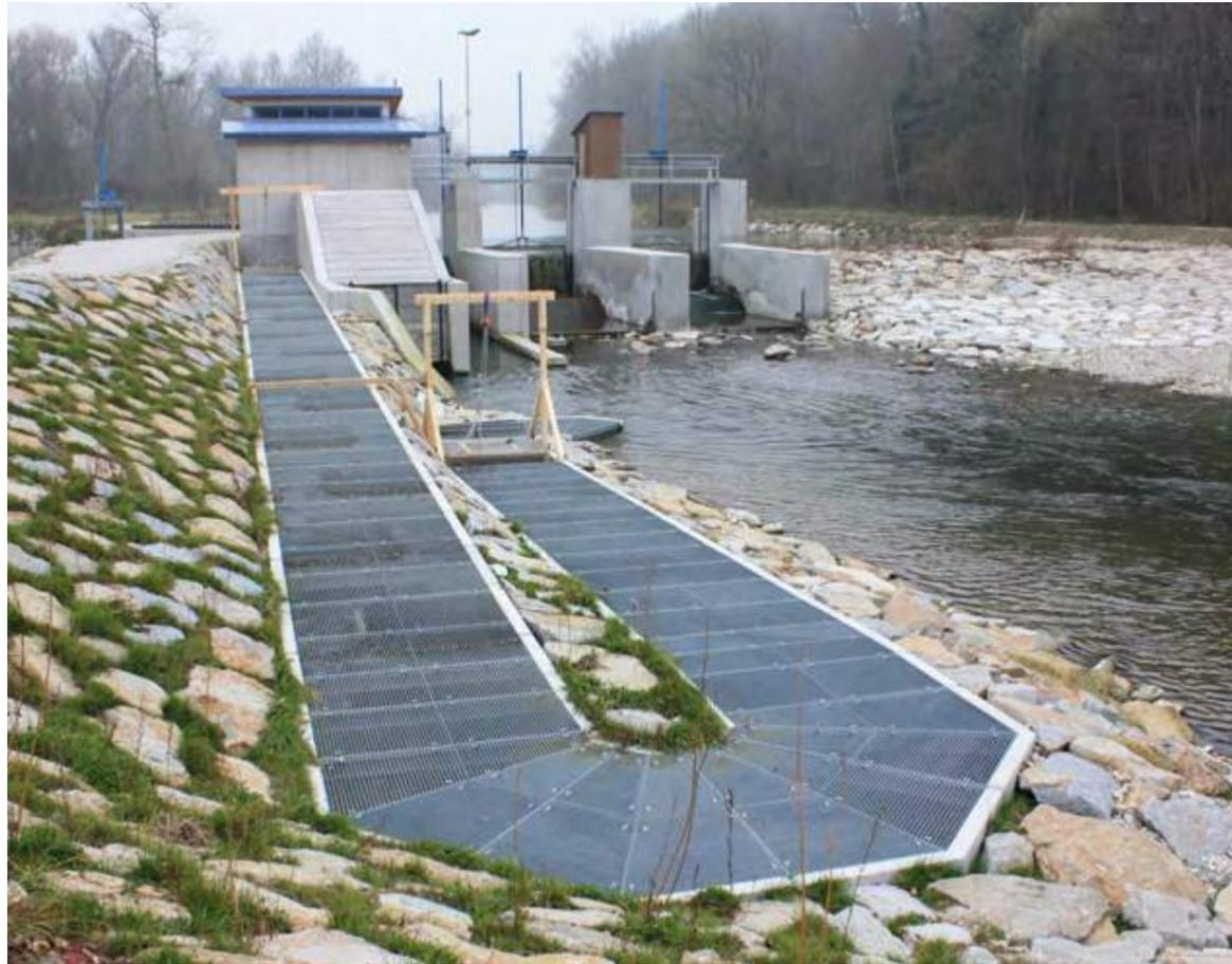
Abb. 2: Prototyp 2, *enature*® Fishpass der Glatzing-Rüstorf Genossenschaft mbH (KWG) am Kraftwerk Hart an der Ager.
