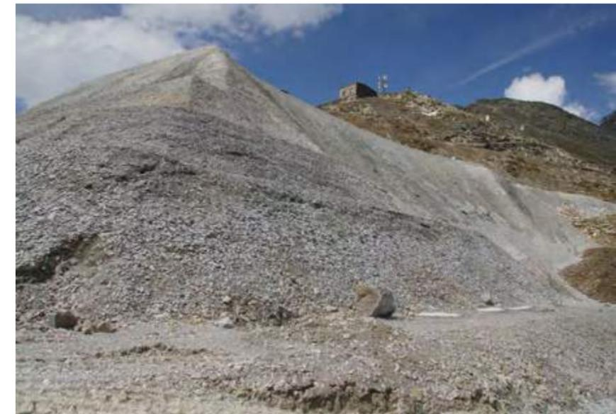
Abb. 4: Zehntausende Quadratmeter in Seehöhen von um 2.200 m, in denen Stollenausbruch abgelagert wurde, wurden mit modernsten Methoden der Hochlagenbegrünung wieder in die Natur eingebunden.
