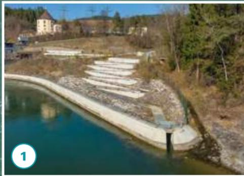
Unterwasserseitiger serpentinartiger Verlauf, im vom Hochwasser beeinflussten Bereich mit Steinschichtung gesichert und mit Gitterrosten abgedeckt.
