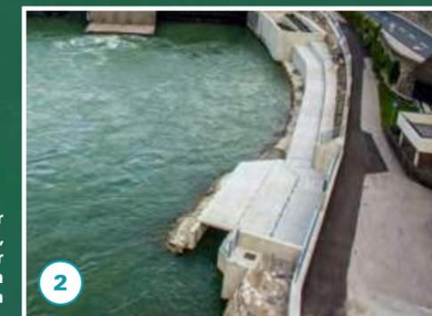
Unterwasserseitiger Trassenverlauf, hochwassersicher mit Betonplatten mit Belichtungselementen abgedeckt.
