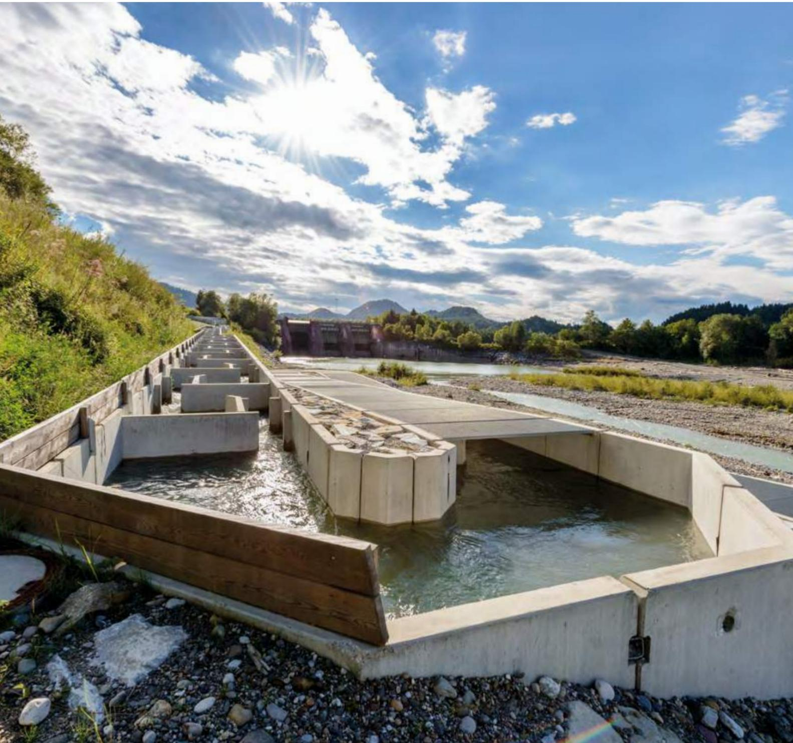
Abb. 4: Fischaufstiegshilfe am VERBUND-Kraftwerk Rosegg-St. Jakob/Wehr St. Martin an der Drau. Die 500 m lange technische Fischwanderhilfe wurde 2013/14 als *enature*® Fishpass errichtet und überwindet einen Höhenunterschied von 16,9 m.
