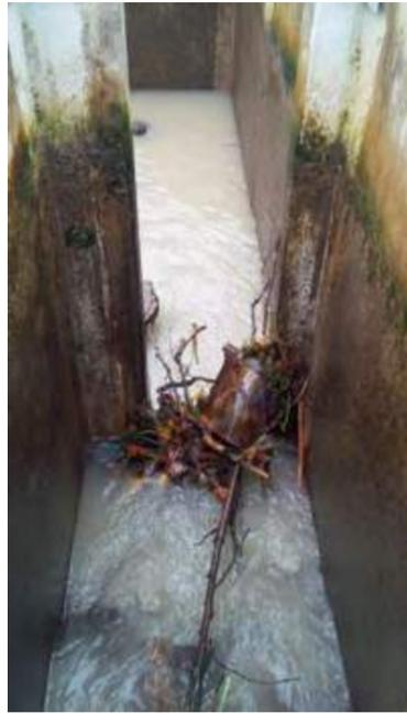
Abb. 6a, b, c: Fischwanderhilfe beim Kraftwerk Rosegg-St. Jakob/Wehr St. Martin an der Drau, Verklausungen durch Eintrag von Totholz und Geschwemmsel.
