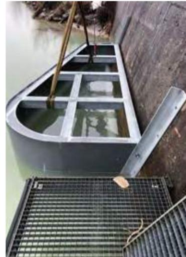
Abb. 21a, b, c: Fischwanderhilfe beim Kraftwerk Annabrücke: Einbau des Geschwemmsel-Abweisers mit Tauchwand im oberwasserseitigen Ausstiegsbereich.
