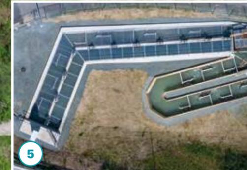
5 Im Verteilbauwerk wird die Dotation der Fischwanderhilfe durch 11 Schieber automatisiert stauspiegelabhängig geregelt.
