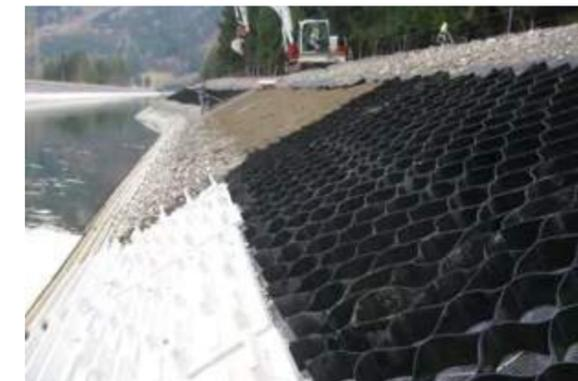
Abb. 7: „SWHS-Renaturierungssystem“ – Systemskizze und Fotostrecke mit: Verankerungsgräben herstellen und Erdanker setzen, Wurzelschutzfolie und Wurzelschutzvlies aufbringen, Montage der Standard- und Ausstiegselemente, Geozellen-Geogitter-Paneele aufbringen, Ausfüllen der Geozellen und Einsaat.
