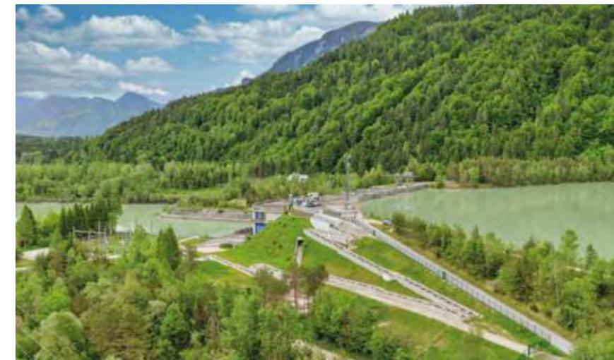
Abb. 6a, b: Europa-Höhenrekord einer technischen Fischwanderhilfe und „Reifeprüfung“ für das Projektteam. Der *enature*® Fishpass am Kraftwerk Annabrücke mit 26 m Höhe und 172 Pools.
