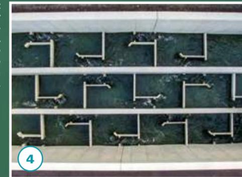
Automatisierte Dotationssteuerung durch stauspiegelabhängige Schiebersteuerung.
