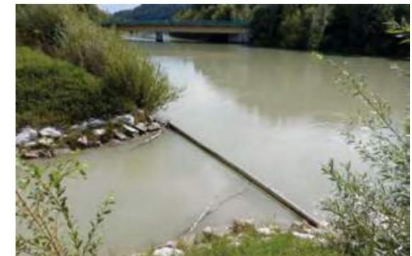
Abb. 9a, b: Fischwanderhilfe beim Kraftwerk Rosegg-St. Jakob/Wehr St. Martin einteiliger und mehrgliedriger Schwimmbaum im oberwasserseitigen Ausstiegsbereich zur Verhinderung von Verklausungen durch Geschiebe- und Schwebstoffeintrag.
