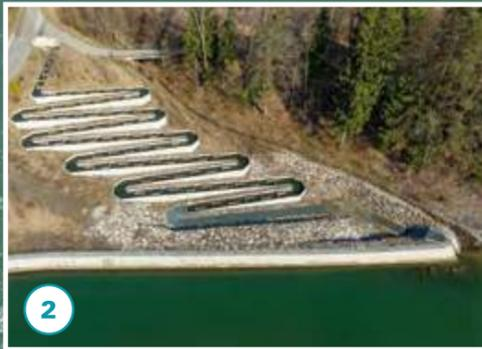
Der Einschnitt in die Böschung wurde durch eine Steinmauer gesichert.
