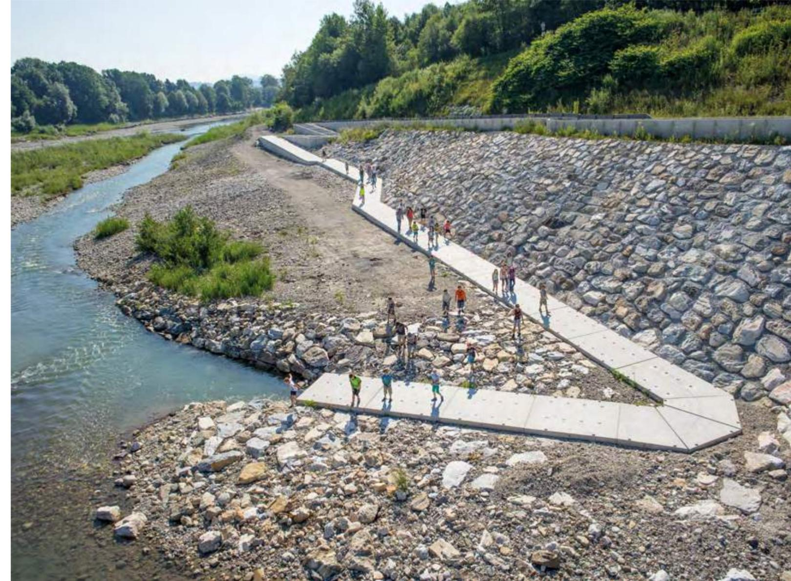
Abb. 11: Fischwanderhilfe beim Kraftwerk Rosegg-St. Jakob/Wehr St Martin, Becken im unterwasserseitigen Einstiegsbereich – nun abgedeckt mit Betonplatten mit integrierten Belichtungsöffnungen, nach Sanierung der Schäden der Hochwässer 2014.
