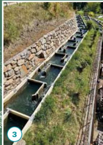
Die Fischwanderhilfe verläuft oberwasserseitig unter dem Niveau des Kraftwerkvorplatzes. Durch senkrechte, über das Gelände ragende Wände konnte eine lange Tunnelvariante vermieden werden.
