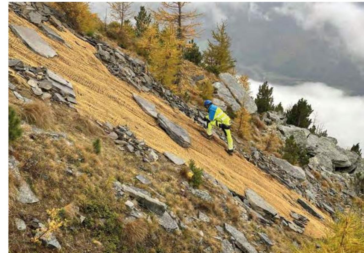
Abb. 16: Mit Kokosmatten gesicherter, verfüllter Künettenbereich, der zusätzlich durch Steinplatten strukturiert wurde.
