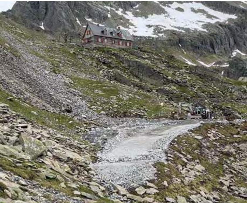
Abb. 13: Beginn der Deponie für das Pumpspeicherkraftwerk Reißeck II plus: Vegetation und Felsplatten werden bergseitig gewonnen und für die Gestaltung der Deponieoberfläche direkt verwendet, dabei werden gleichzeitig die Haldenbereiche der Nachkriegsbaustelle in der linken Bildhälfte in die Natur eingebunden.
