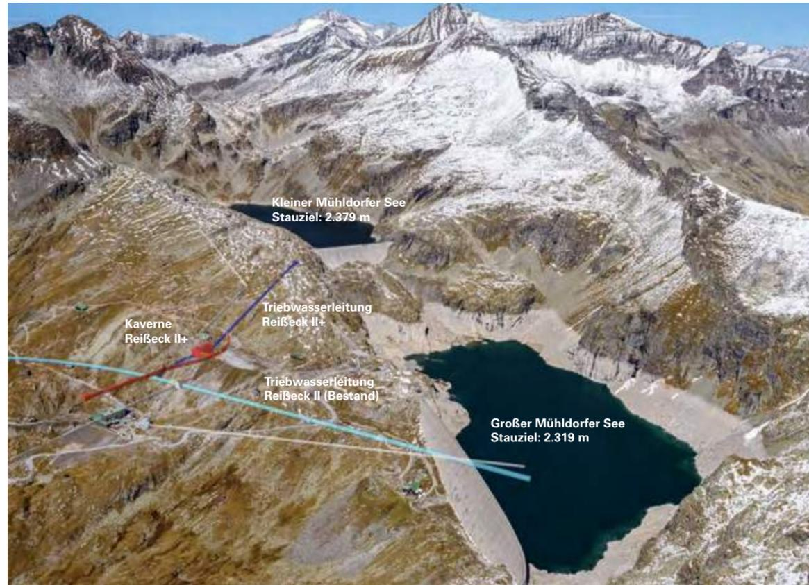
Abb. 1 (vorhergehende Seite): Systemskizze vor Fotohintergrund: Pumpspeicherkraftwerk Reißeck II.
