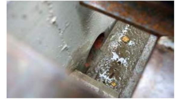
Abb. 21: Bei allen Weiderosten, die im Zusammenhang mit Reißeck II angelegt wurden, ermöglicht ein ebenerdig angebundenes Rohr ein problemloses Verlassen der Betongrube unter dem Weiderost.
