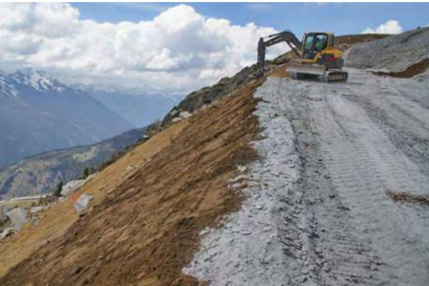
Abb. 5: Mit dem Höherwachsen der Deponie erfolgte sukzessive der Oberbodenauftrag und die Stabilisierung des Oberbodens durch Kokosmatten.
