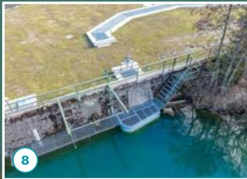
Wartungssteg am oberwasserseitigen Ausstieg mit Tauchwand zur Geschwemmel- und Totholزابwehr.
